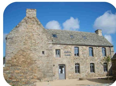
L'ancienne mairie était non isolée et chauffée via une chaudière au fioul vétuste et un réseau hydraulique obsolète. Elle présentait une performance énergétique globale de 268 kWh<sub>ep</sub>/m<sup>2</sup>/an, avec une moyenne de 2700 litres de fioul par an pour 115 m<sup>2</sup> chauffés.
